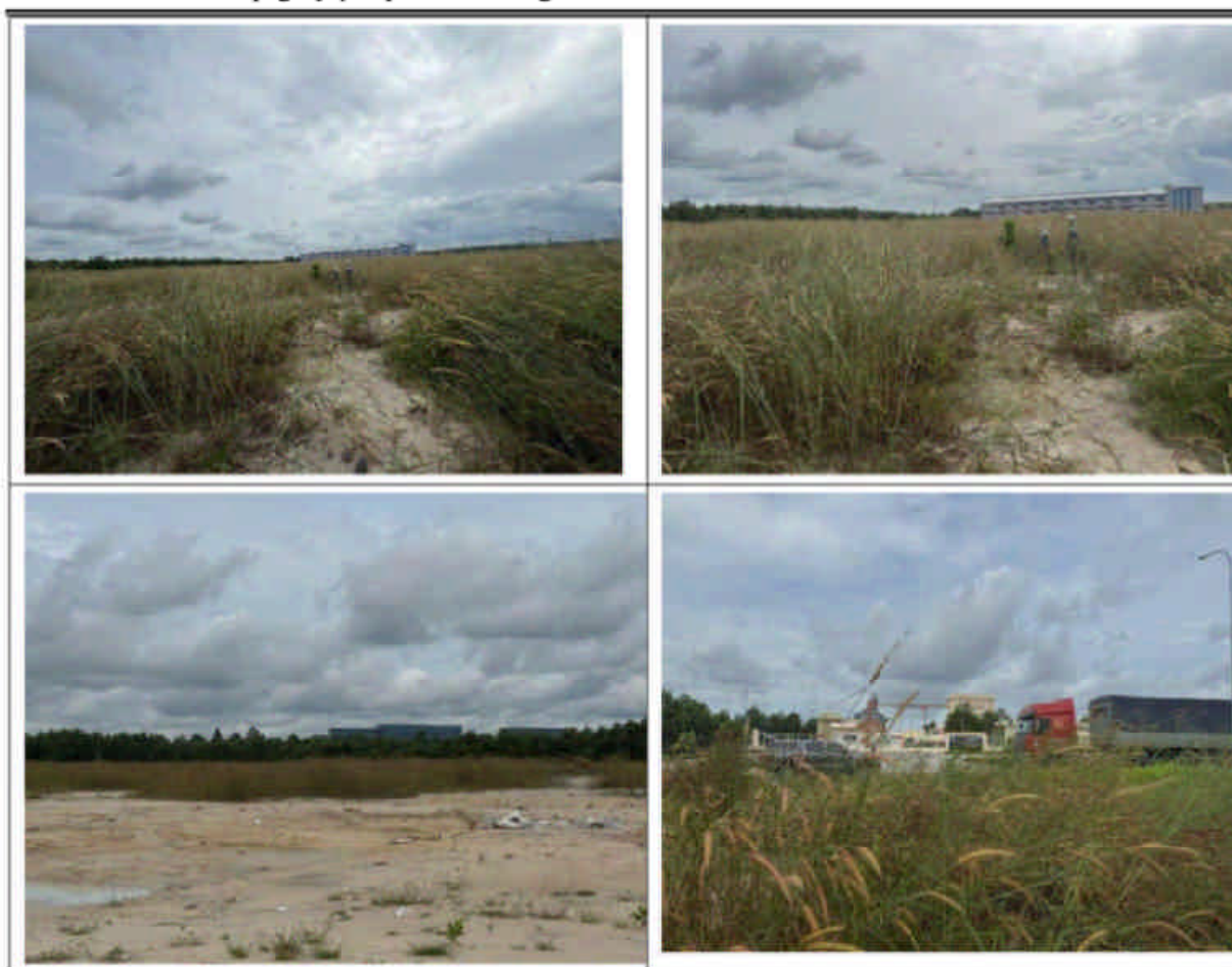
Hình 1.8: Hình ảnh hiện trạng khu đất dự án
